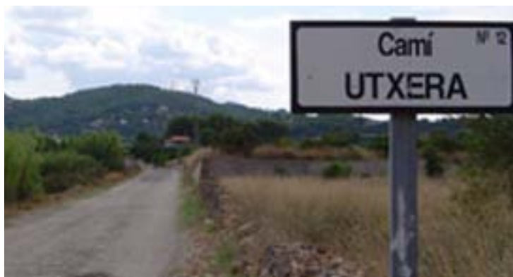
Aspecte de l'asfaltat del camí de l'Utxera i del camí de la Font de Poveda
