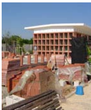
Obres actuals en el cementeri. / R. VICENT
